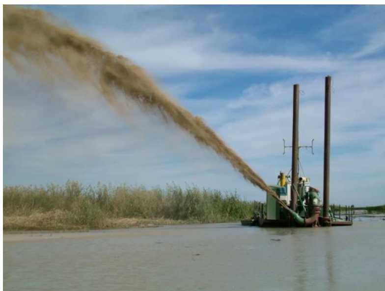
Рис.39 Дноуглубительные работы на ВКМСК https://www.astrobl.ru
