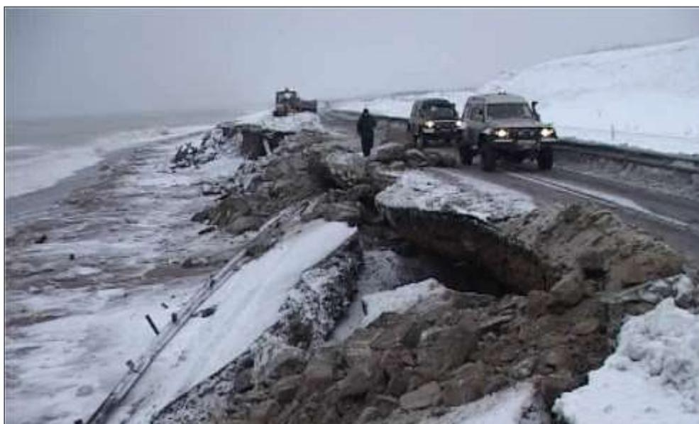
*Рисунок 6.1 – Разрушение уступа морской террасы с расположенной на ней автомагистралью (03.01.2010 г)*
