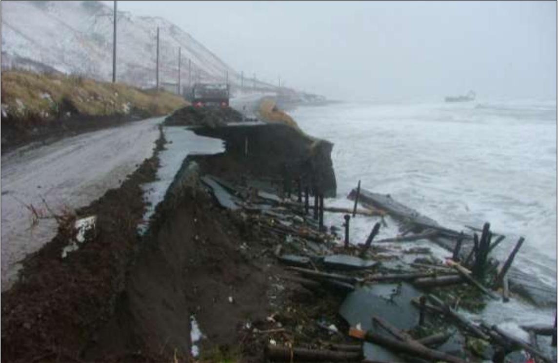
*Рисунок 7.2 – Разрушение дорожного полотна на участке км 5+750-км5+820 автодороги Невельск – Шебунино после подмыва и опрокидывания бетонной волноотбойной стенки, построенной в 30-е годы*
