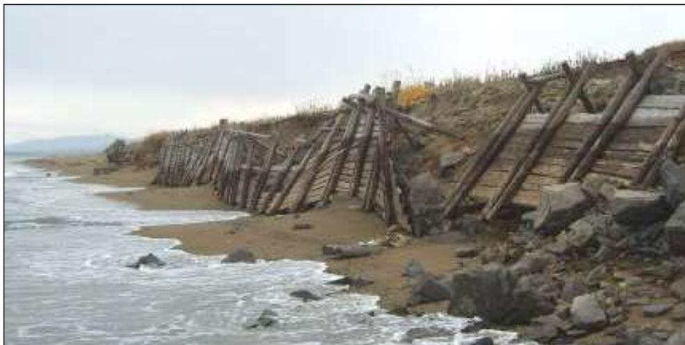
*Рисунок 7.7 – Разрушение деревянной волноотбойной стенки, построенной в 90-е годы, в районе п. Взморье (зал. Терпения)*
