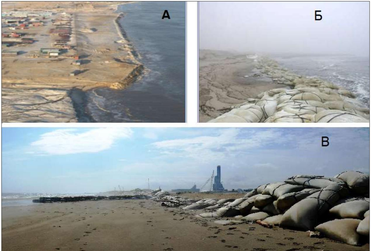
Рисунок 7.38 – Разрушение временной берегозащиты. А – 2004 г., Б – 2005 г., В – 2012 г.
