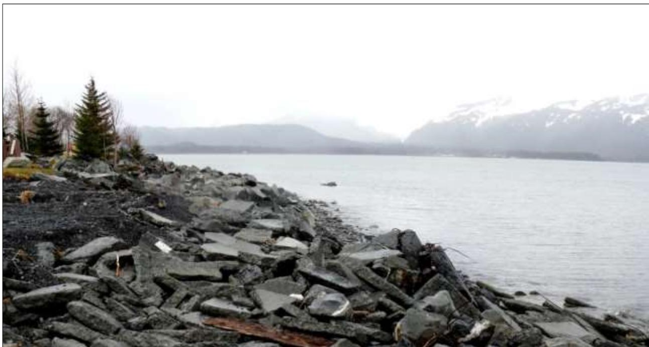
*Рисунок 7.25 – Защита берегов строительными отходами (г. Сьюард, Аляска)*
