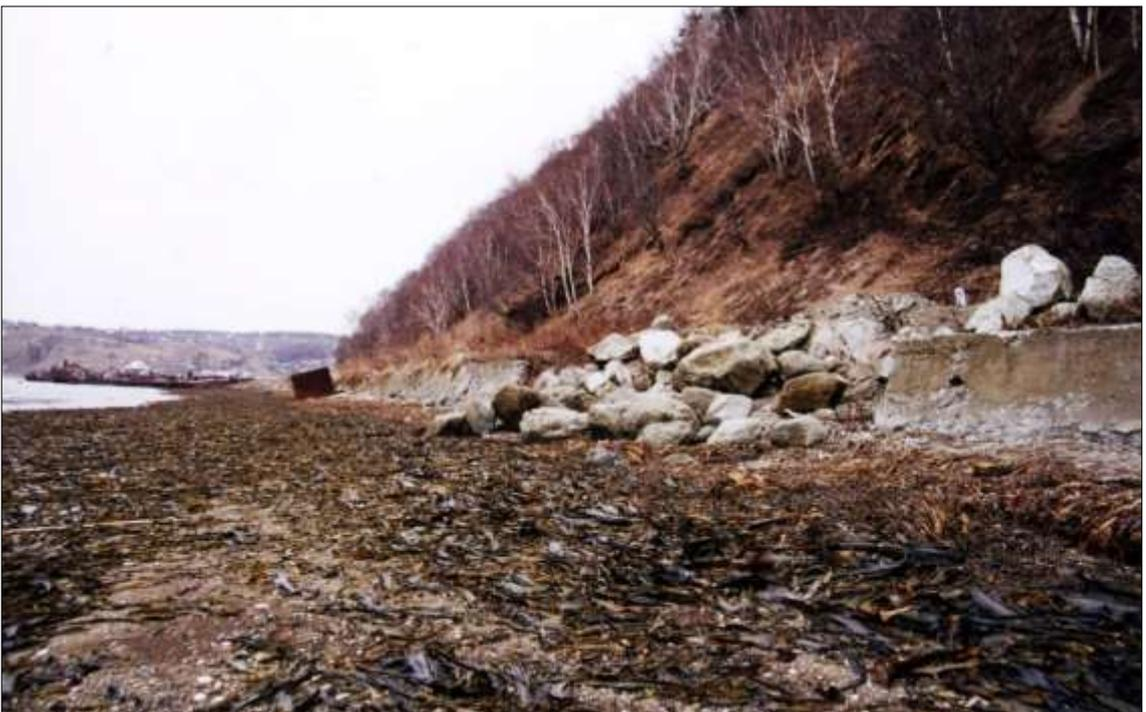
*Рисунок 7.5 – Каменная наброска на разрушенном участке волноотбойной бетонной стенки, построенной в 30-е годы на ж/д перегоне Южно-Сахалинск – Корсаков (зал. Анива)*
