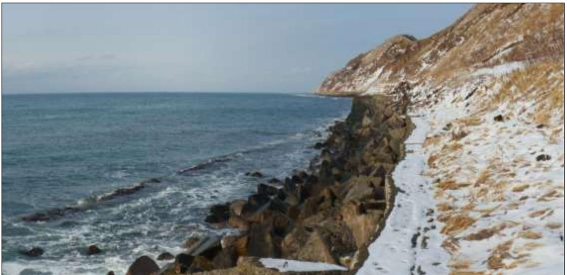
*Рисунок 7.3 – Остатки волноотбойной бетонной стенки, построенной в 30-е годы на 102-103 км перегона Пионеры – Чехов железной дороги Невельск – Ильинск и действующая волноотбойная стенка, прикрытая тетраэдрами (построена в 60-м году)*
