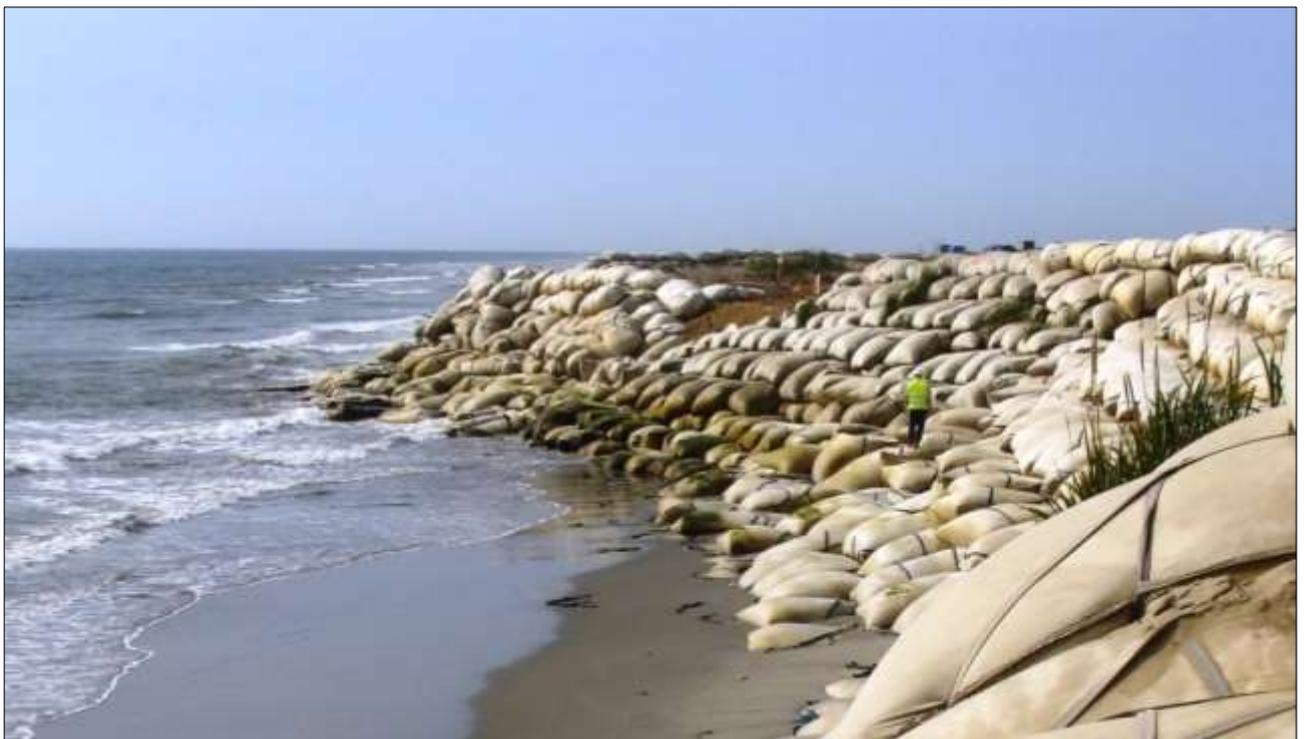
*Рисунок 3.47 – Временная берегозащита протяженностью около 800 м на пересыпи лагуны Чайво (2003-2019 гг.)*
