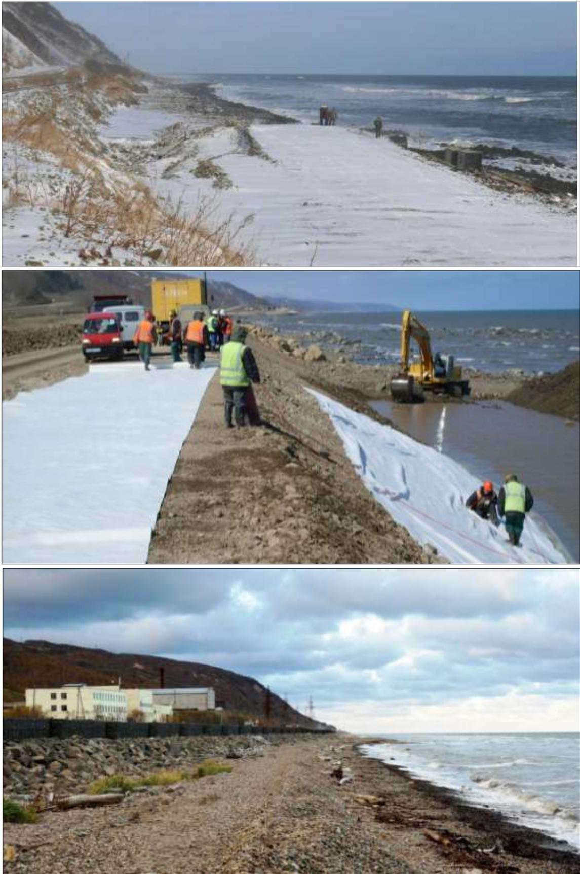
*Рисунок 7.11 – Строительство берегозащиты дороги общего пользования Южно-Сахалинск – Оха – Москальво на участке км 182+700 – км 197*
