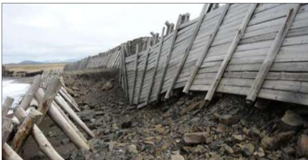
*Рисунок 7.8 – Разрушение деревянной волноотбойной стенки в районе п. Шахтерск (Татарский пролив)*
