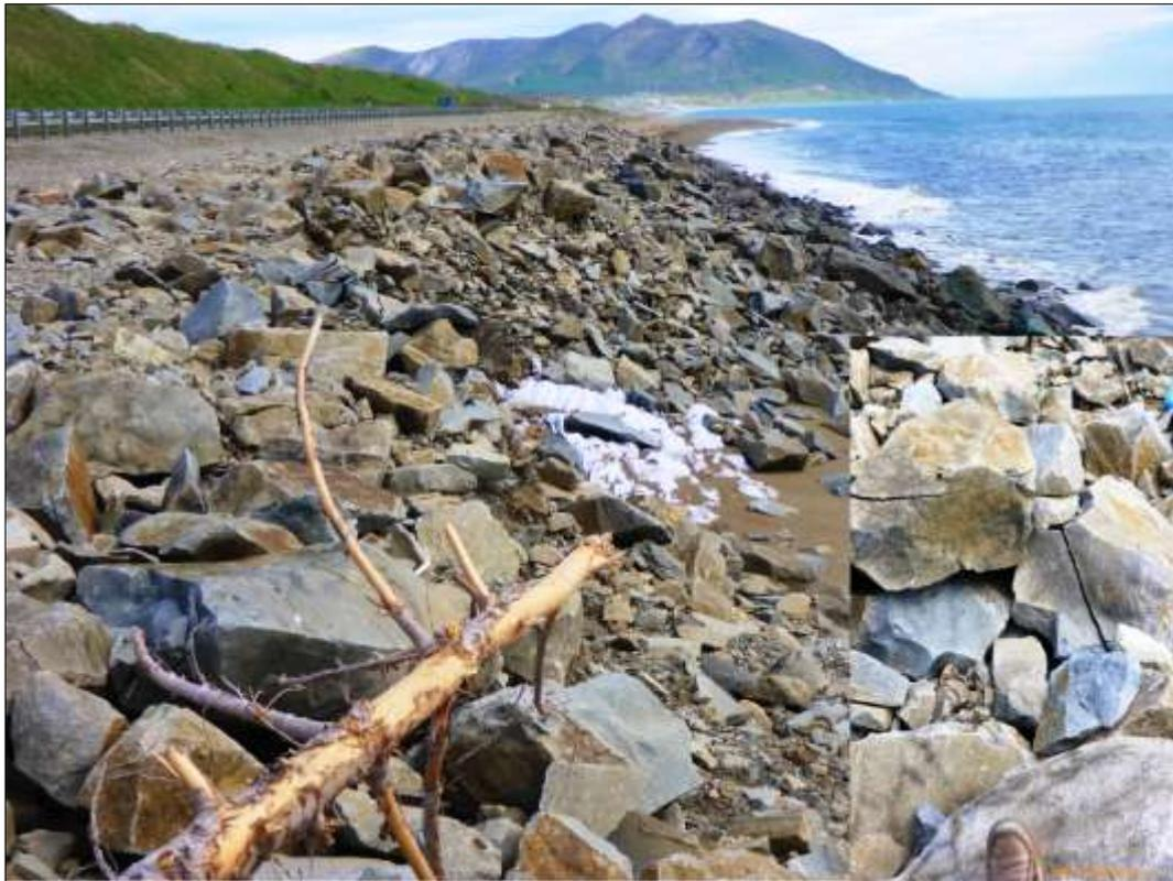
*Рисунок 3.7 – Разрушение природного камня дацитового состава берегозащитной конструкции вследствие низкой морозостойкости*
