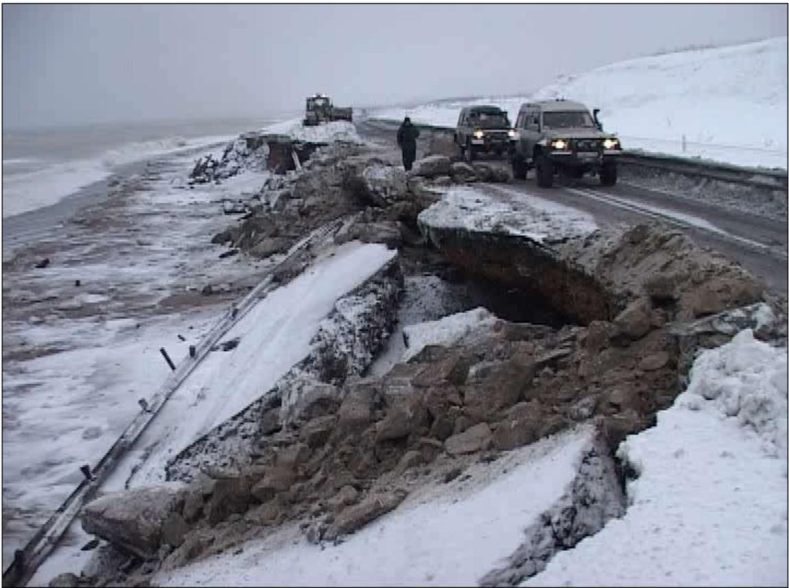
*Рисунок 7.13. Разрушение автодороги, связывающей юг и север Сахалина.*
