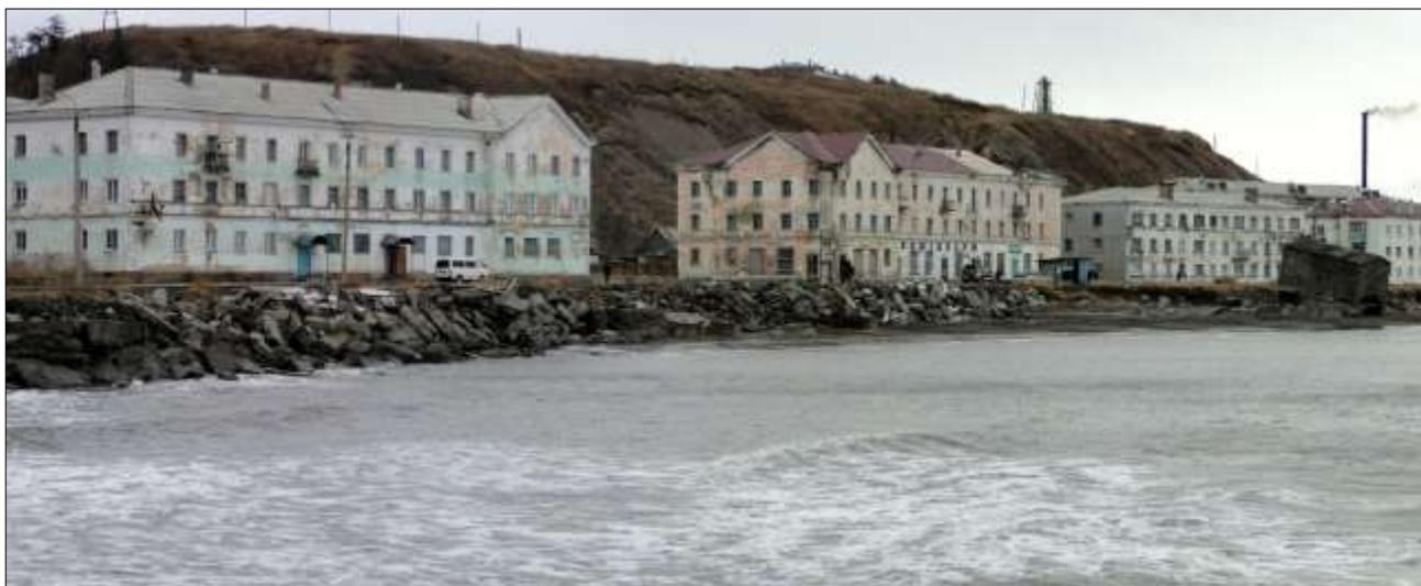
*Рисунок 7.28 – Защита строительным мусором домов по ул. Приморской (г. Углегорск)*
