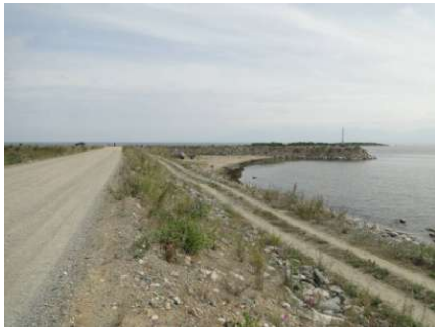
Рисунок 3.20 – Каменнонабросные сооружения, возведенные в устье р.Кичера по Нижнеангарской косе. Август 2013 г.
