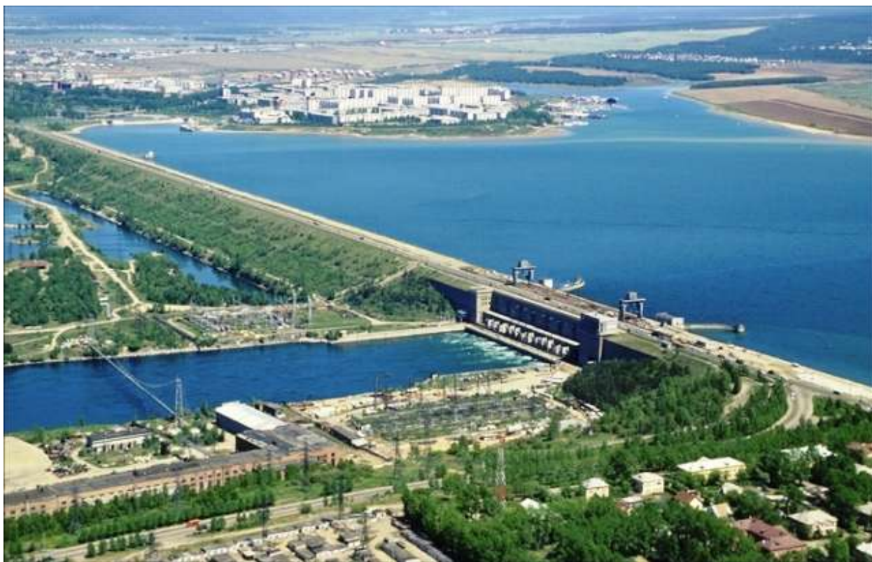
Рисунок 1.2 – Плотина Иркутской ГЭС
