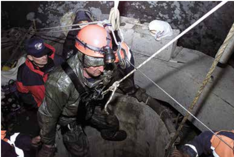
Рис. 41. Спуск водолаза через 70-метровую скважину в тоннель, заполненный водой и камнями. Фото сайта www.15.mchs.gov.ru
