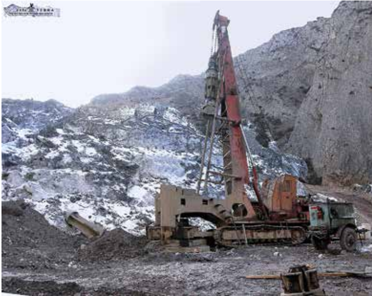
Рис. 40. Скважины над тоннелем пробивает буровая установка «Като»
