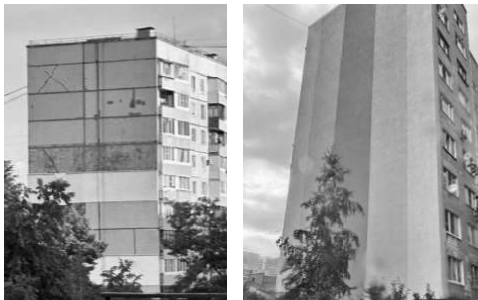
Рис. 1. Состояние ограждающих конструкций типового крупнопанельного 9-этажного здания в 2 км от плотины после частичного (слева) и полного (справа) ремонта торца. Состояние на 2025 г. (фото автора)
