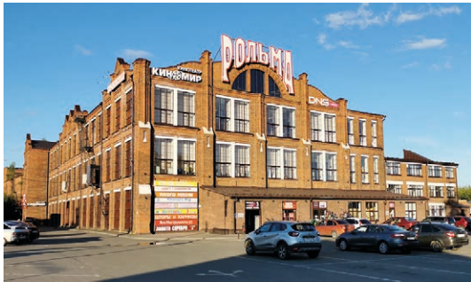
Рис. 4.8.2. Ростов. Торговый центр в здании фабрики «Рольма»*.
