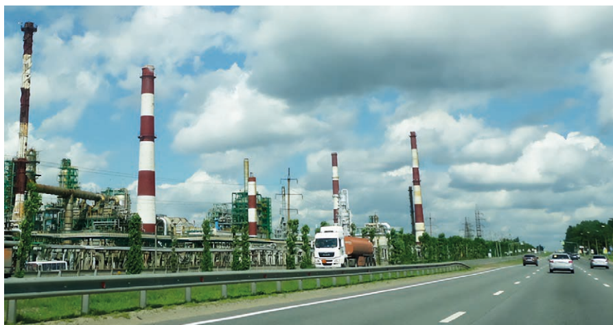
Рис. 4.4.4. Нефтеперерабатывающий завод «Славнефть-ЯНОС» на южной окраине Ярославля.
