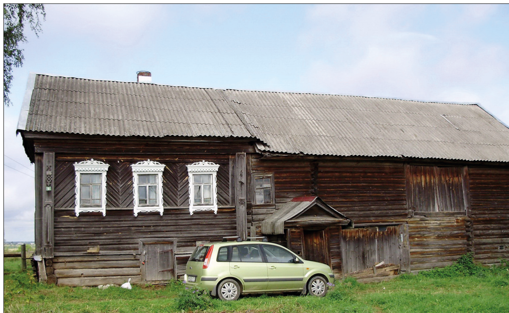
Рис. 3.5.2. Типичный деревенский дом в Костромской области из двух состыкованных срубов: жилой и хозяйственной зоны (в широкие ворота сарая по пандусу на второй этаж въезжали телеги с сеном). Ныне используется московскими дачниками.
