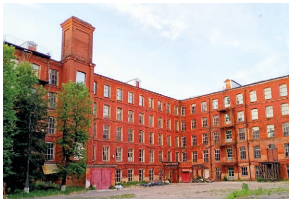
Рис. 4.4.2. Ярославль. Корпуса современной фабрики «Красный Перекоп».*
