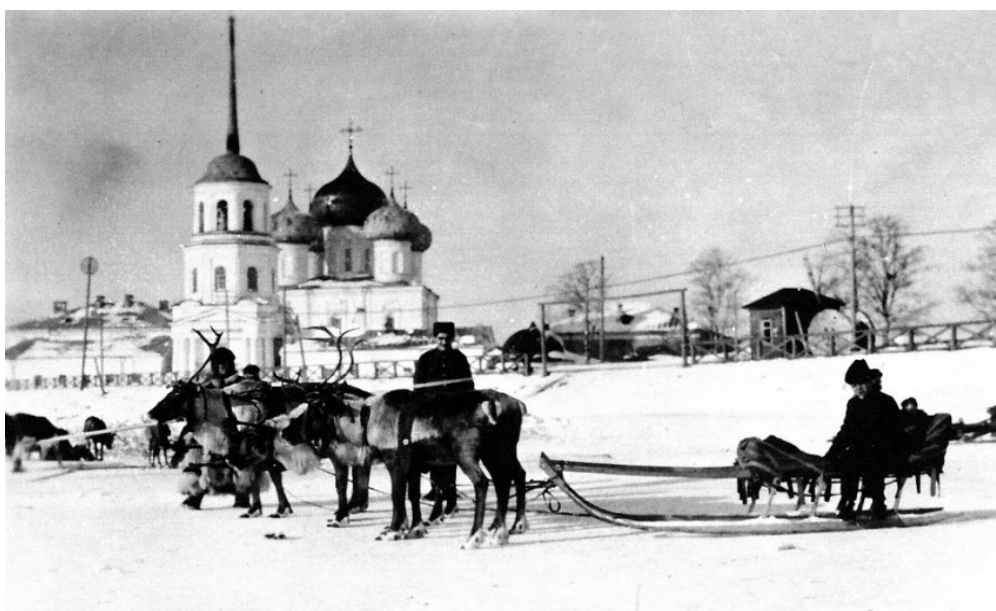
Рис. 7 Вид на монастырь со льда Северной Двины, с западной стороны. Фотография декабря 1918 года работы американского фотографа [10]. Fig. 7 View of the monastery from the ice of the Northern Dvina, from the west side. Photo of December 1918 by an American photographer.
