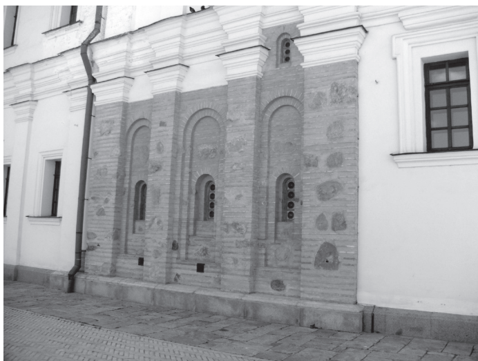
Успенский собор в Киеве. Разрушен в 1941 г. Воссоздан в барочных формах XVIII века в середине 1990-х-2000 г. На фото северная стена собора, имитирующая «раскрытие подлинной исторической древней кладки», которой здесь не сохранилось. Территория объекта Всемирного наследия
