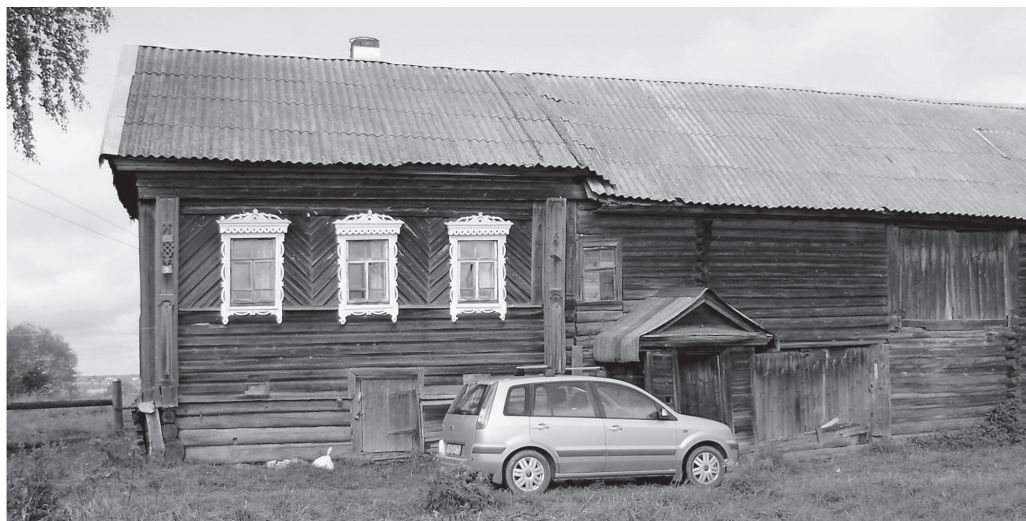
Типичный дом на Ближнем Севере из двух состыкованных срубов: жилой части и хозяйственной (внизу скотный двор, над ним сеновал, в широкие ворота которого по пандусу въезжали телеги с сеном)
